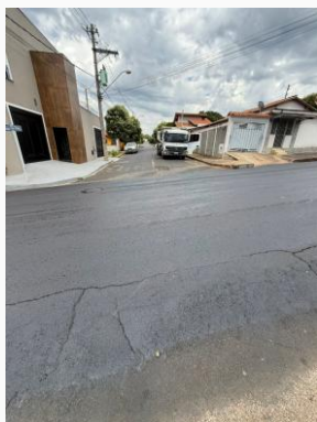
Foto 5 — Foto 05 - TRANSPORTE DE CBUQ COM CAMINHÃO BASCULANTE - RUA JERONIMO FERREIRA — Data: 27/08/2026
