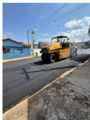
Foto 10 — Foto 10 - COMPACTAÇÃO DO CONCRETO ASFÁLTICO COM ROLO DE PNEU DA RUA JERONIMO FERREIRA — Data: 27/08/2026
