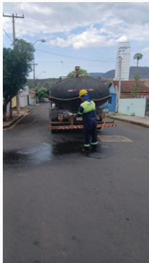
Foto 3 — Foto 03 - LIMPEZA DE SUPERFÍCIE COM JATO DE ALTA PRESSÃO DA RUA JERONIMO FERREIRA — Data: 27/08/2026
