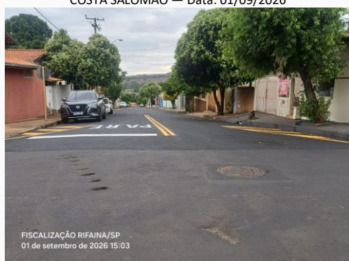
Foto 27 — Foto 27 - SERVIÇO DE ENGENHARIA CONCLUÍDO (INFRAESTRUTURA URBANA - RECAPEAMENTO ASFALTICO E SINALIZAÇÃO VIÁRIA HORIZONTAL) DA RUA JERONIMO FERREIRA — Data: 01/09/2026
