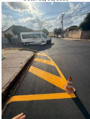
Foto 19 — Foto 19 -PINTURA DE SINALIZAÇÃO VIÁRIA HORIZONTAL COM TINTA RETRORREFLETIVA A BASE DE RESINA ACRÍLICA COM MICROESFERAS DE VIDRO DA RUA JERONIMO FERREIRA — Data: 31/08/2026
