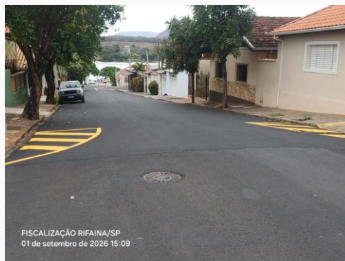
Foto 30 — Foto 30 - SERVIÇO DE ENGENHARIA CONCLUÍDO (INFRAESTRUTURA URBANA - RECAPEAMENTO ASFALTICO E SINALIZAÇÃO VIÁRIA HORIZONTAL) DA RUA CORONEL PEREIRA CASSIANO — Data: 01/09/2026
