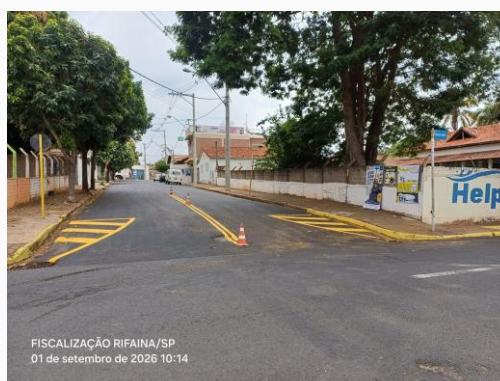
Foto 26 — Foto 26 -PINTURA DE SINALIZAÇÃO VIÁRIA HORIZONTAL COM TINTA RETRORREFLETIVA A BASE DE RESINA ACRÍLICA COM MICROESFERAS DE VIDRO DA RUA ISALTINA DA COSTA SALOMÃO — Data: 01/09/2026
