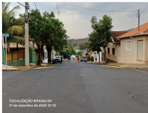
Foto 24 — Foto 24 -PINTURA DE SINALIZAÇÃO VIÁRIA HORIZONTAL COM TINTA RETRORREFLETIVA A BASE DE RESINA ACRÍLICA COM MICROESFERAS DE VIDRO DA RUA CORONEL PEREIRA CASSIANO — Data: 01/09/2026
