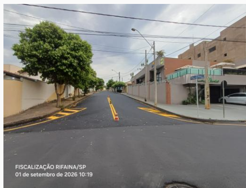
Foto 22 — Foto 22 -PINTURA DE SINALIZAÇÃO VIÁRIA HORIZONTAL COM TINTA RETRORREFLETIVA A BASE DE RESINA ACRÍLICA COM MICROESFERAS DE VIDRO DA RUA JERONIMO FERREIRA — Data: 01/09/2026
