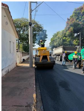
Foto 17 — Foto 17 - COMPACTAÇÃO DO CONCRETO ASFALTICO COM ROLO CHAPA DA RUA ISALTINA DA COSTA SALOMÃO — Data: 28/08/2026
