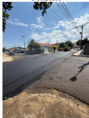
Foto 8 — Foto 08 - COMPACTAÇÃO DO CONCRETO ASFÁLTICO COM ROLO CHAPA DA RUA JERONIMO FERREIRA — Data: 27/08/2026
