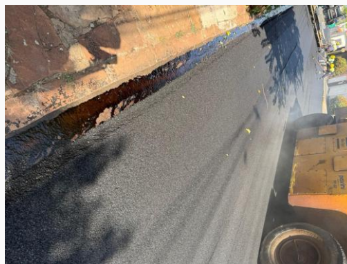
Foto 12 — Foto 12 - EXECUÇÃO DE PAVIMENTO COM APLICAÇÃO DE CONCRETO ASFÁLTICO, CAMADA DE ROLAMENTO DA RUA CORONEL PEREIRA CASSIANO — Data: 27/08/2026
