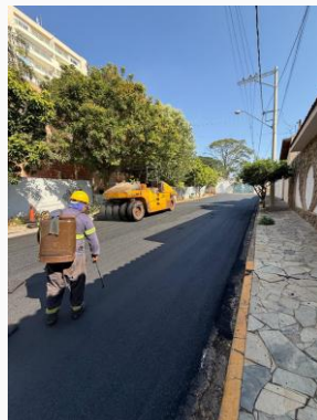
Foto 18 — Foto 18 - COMPACTAÇÃO DO CONCRETO ASFALTICO COM ROLO CHAPA DE PNEU DA RUA ISALTINA DA COSTA SALOMÃO — Data: 28/08/2026
