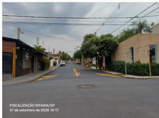
Foto 23 — Foto 23 -PINTURA DE SINALIZAÇÃO VIÁRIA HORIZONTAL COM TINTA RETRORREFLETIVA A BASE DE RESINA ACRÍLICA COM MICROESFERAS DE VIDRO DA RUA CORONEL PEREIRA CASSIANO — Data: 01/09/2026
