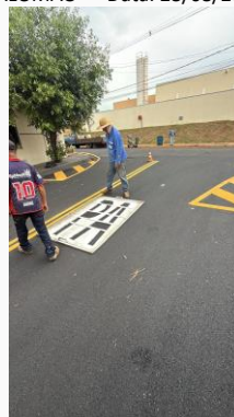
Foto 20 — Foto 20 -PINTURA DE SINALIZAÇÃO VIÁRIA HORIZONTAL COM TINTA RETRORREFLETIVA A BASE DE RESINA ACRÍLICA COM MICROESFERAS DE VIDRO DA RUA JERONIMO FERREIRA — Data: 01/08/2026
