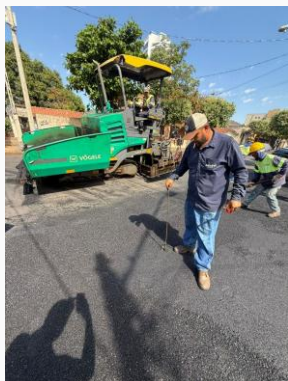
Foto 7 — Foto 07 - EXECUÇÃO DE PAVIMENTO COM APLICAÇÃO DE CONCRETO ASFÁLTICO, CAMADA DE ROLAMENTO DA RUA JERONIMO FERREIRA — Data: 27/08/2026
