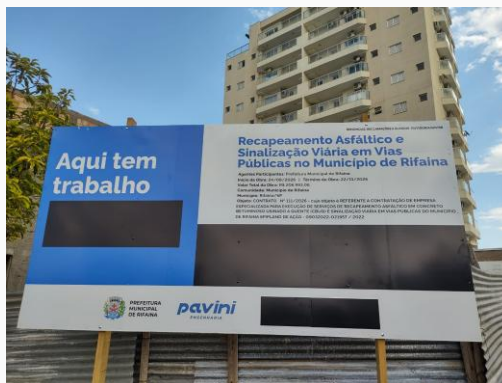
Foto 2 — Foto 02 - PLACA DE OBRA COM CHAPA GALVANIZADA E ESTRUTURA DE MADEIRA — Data: 27/08/2026
