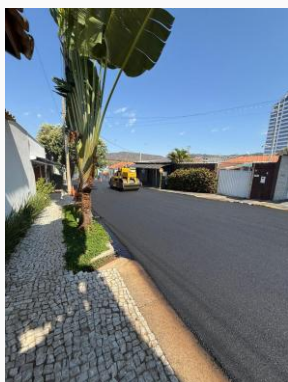
Foto 13 — Foto 13 - COMPACTAÇÃO DO CONCRETO ASFÁLTICO COM ROLO CHAPA DA RUA CORONEL PEREIRA CASSIANO — Data: 27/08/2026
