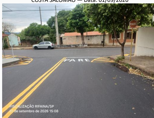
Foto 28 — Foto 28 - SERVIÇO DE ENGENHARIA CONCLUÍDO (INFRAESTRUTURA URBANA - RECAPEAMENTO ASFALTICO E SINALIZAÇÃO VIÁRIA HORIZONTAL) DA RUA JERONIMO FERREIRA — Data: 01/09/2026
