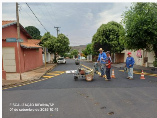
Foto 21 — Foto 21 -PINTURA DE SINALIZAÇÃO VIÁRIA HORIZONTAL COM TINTA RETRORREFLETIVA A BASE DE RESINA ACRÍLICA COM MICROESFERAS DE VIDRO DA RUA JERONIMO FERREIRA — Data: 01/09/2026
