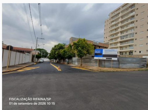
Foto 25 — Foto 25 -PINTURA DE SINALIZAÇÃO VIÁRIA HORIZONTAL COM TINTA RETRORREFLETIVA A BASE DE RESINA ACRÍLICA COM MICROESFERAS DE VIDRO DA RUA ISALTINA DA COSTA SALOMÃO — Data: 01/09/2026
