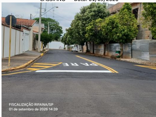
Foto 31 — Foto 31 - SERVIÇO DE ENGENHARIA CONCLUÍDO (INFRAESTRUTURA URBANA - RECAPEAMENTO ASFALTICO E SINALIZAÇÃO VIÁRIA HORIZONTAL) DA RUA ISALTINA DA COSTA SALOMÃO — Data: 01/09/2026
