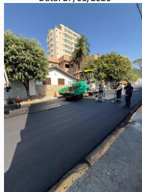
Foto 16 — Foto 16 - EXECUÇÃO DE PAVIMENTO COM APLICAÇÃO DE CONCRETO ASFÁLTICO, CAMADA DE ROLAMENTO DA RUA ISALTINA DA COSTA SALOMÃO — Data: 28/08/2026
