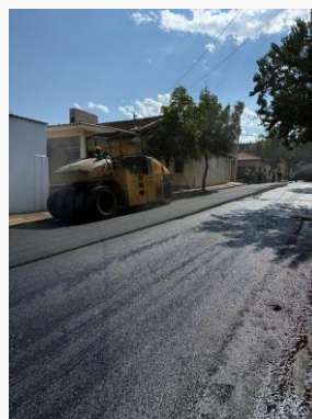
Foto 14 — Foto 14 - COMPACTAÇÃO DO CONCRETO ASFÁLTICO COM ROLO CHAPA DA RUA CORONEL PEREIRA CASSIANO — Data: 27/08/2026
