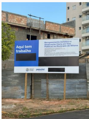
Foto 1 — Foto 01 - PLACA DE OBRA COM CHAPA GALVANIZADA E ESTRUTURA DE MADEIRA — Data: 27/08/2026
