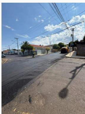
Foto 9 — Foto 09 - COMPACTAÇÃO DO CONCRETO ASFÁLTICO COM ROLO DE PNEU DA RUA JERONIMO FERREIRA — Data: 27/08/2026
