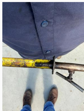
Foto 6 — Foto 06 - ESPETO PARA MEDIR ESPESSURA DO CONCRETO ASFALTICO DA RUA JERONIMO FERREIRA — Data: 27/08/2026
