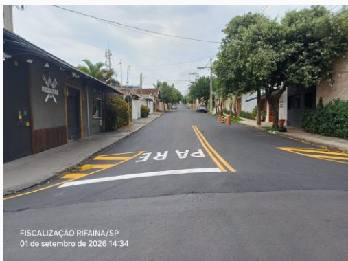
Foto 29 — Foto 29 - SERVIÇO DE ENGENHARIA CONCLUÍDO (INFRAESTRUTURA URBANA - RECAPEAMENTO ASFALTICO E SINALIZAÇÃO VIÁRIA HORIZONTAL) DA RUA CORONEL PEREIRA CASSIANO — Data: 01/09/2026
