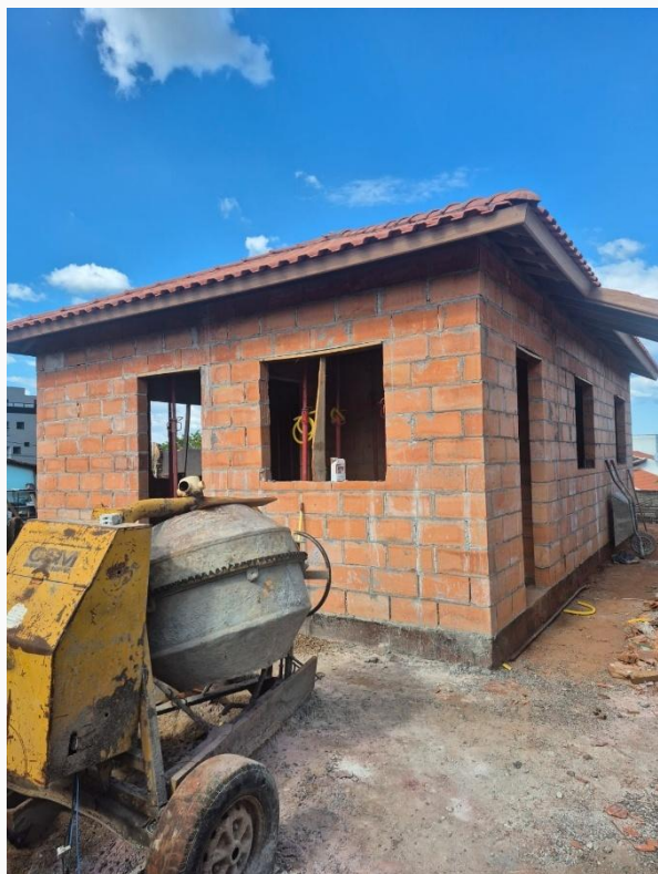
Foto 01 – alvenaria de bloco cerâmico
