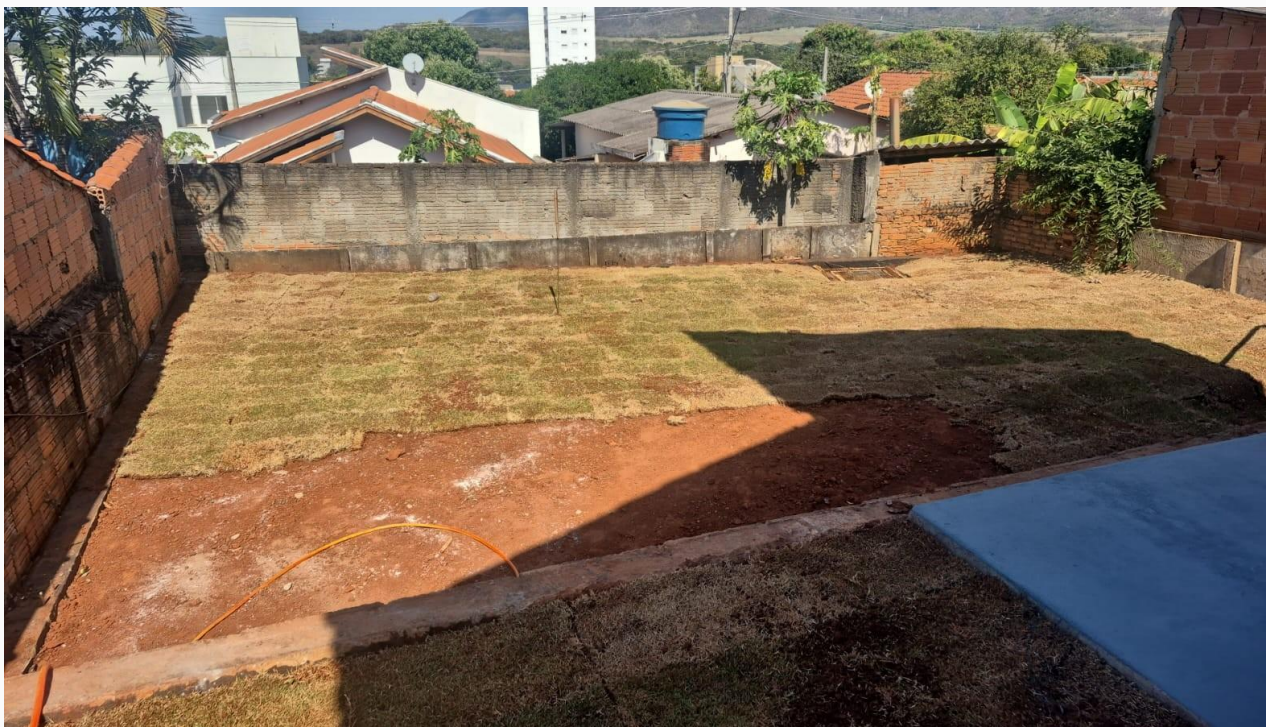
Foto 02 – muro de arrimo
