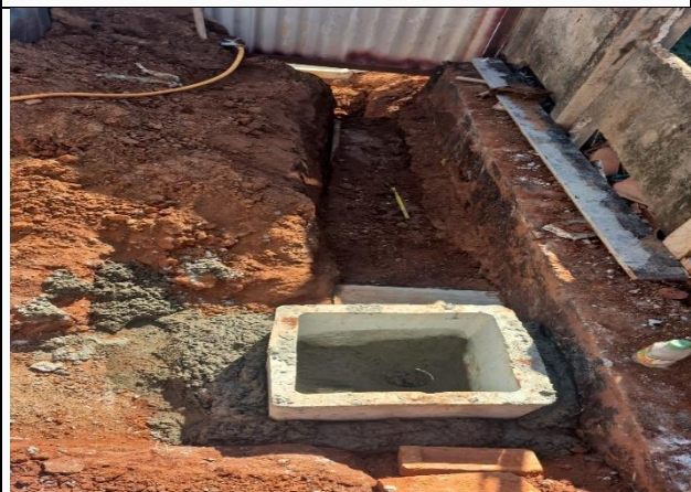
Foto 25 – caixas pluviais.
