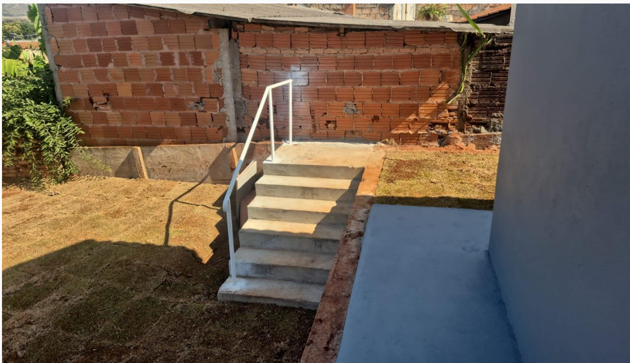
Foto 01 – escada de acesso
