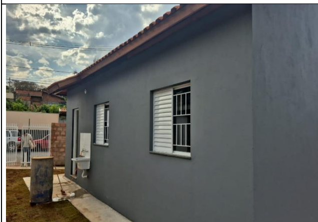
Foto 07 – lateral da lavanderia.
