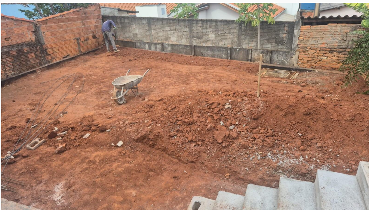
Foto 01 – muro de arrimo
