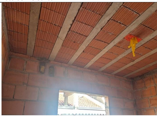
Foto 10 – corrugado e caixa laje.
